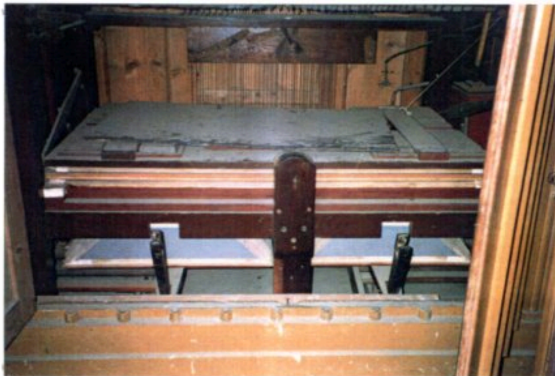
Vue générale de la soufflerie au démontage
