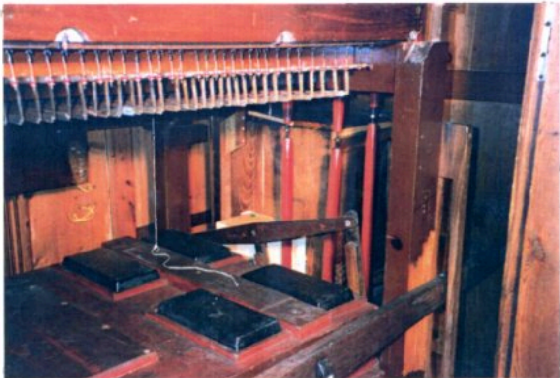
Vue intérieure avec un détail de la charpente
